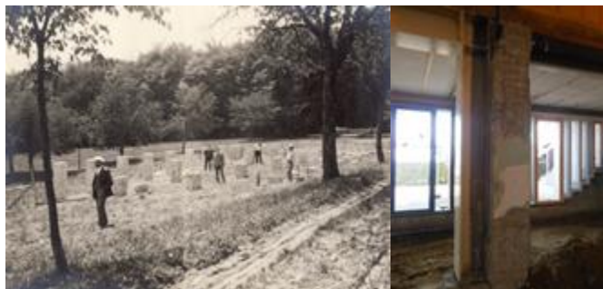
Juin 1920 : Début des travaux de la 1 ère grande salle
